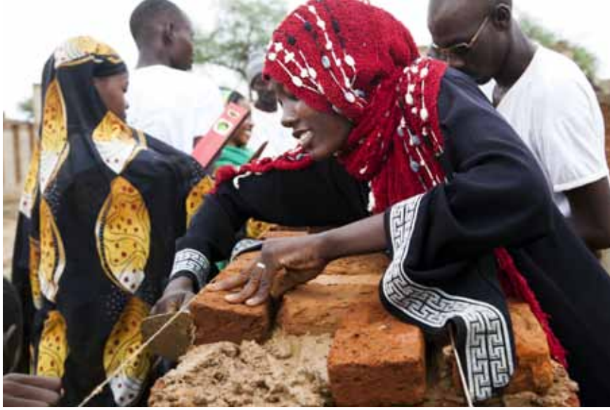
في ٧ أكتوبر ٢٠١٢، شباب يعملون في الثورة شمال، شمال دارفور لإكمال مركز اجتماعي باحد مشاريع اليوناميد المجتمعية كثيفة العمالة. تصوير سجاد القرابي، اليوناميد.
